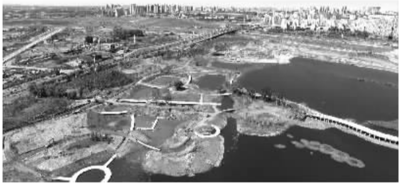
南四环桥以北施工后
