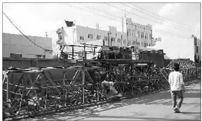
被“肢解”的塔吊在路边放了两年
